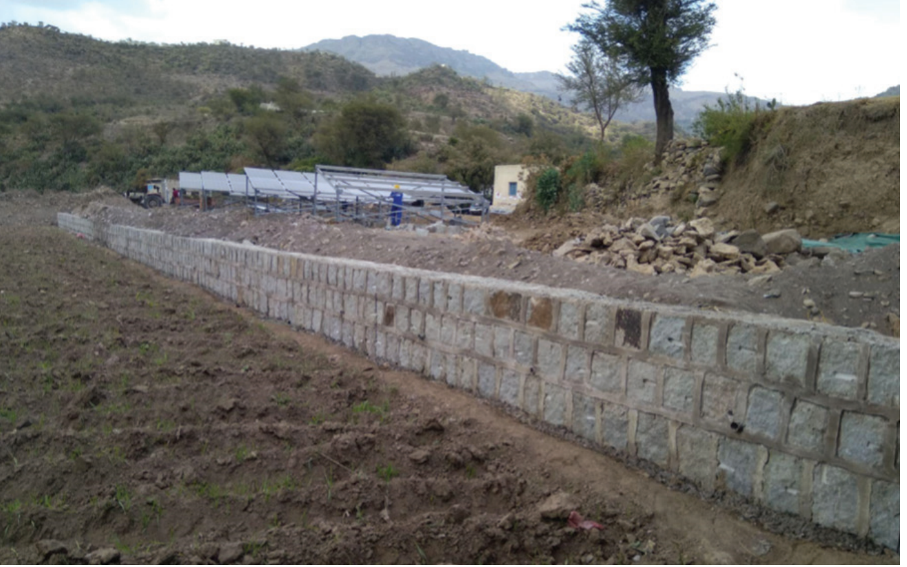
تم بناء جدران سائدة عند البئر لحمايته من السيول، زامح، إب. صورة: مكتب الأمم المتحدة لخدمات المشاريع 2023م.
