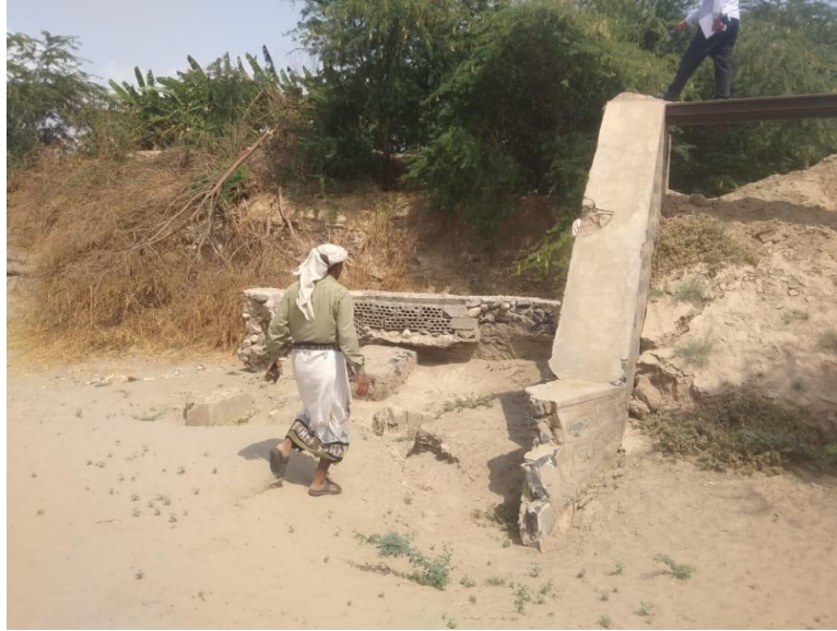
الصورة 3.1: بوابات تحكم وإطارات بوابات تالفة في وادي بنا، أبين - الصورة لبرنامج الأمم المتحدة الإنمائي في اليمن، مارس 2022م
